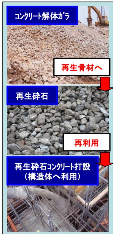
再生砕石コンクリートを構造躯体およびコンクリート二次製品(下写真参照)に利用可能
